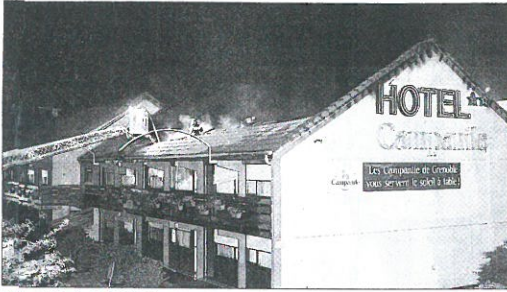
Quelques 500 m 2 ont été détruits cette nuit.
