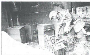
Le 27 mars dernier, l'école maternelle du groupe scolaire Joseph-Valier à Grenoble avait été victime de nombreuses dégradations. Plusieurs salles et le bureau de la directrice avaient été saccagés. De la peinture et de la colle avaient été répandues abondamment sur les murs, les sols et un bureau.
