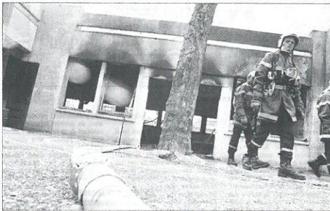
Quelque 300 m 2 du bâtiment B ont été ravagés par les flammes. Par ailleurs, quatre classes ont été sérieusement endommagées. Photos Cyril SOLLIER
